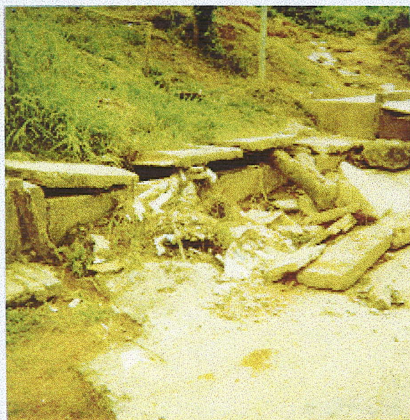
Rua Cruz Gonçalves, 250 galeria com desbarrido.
