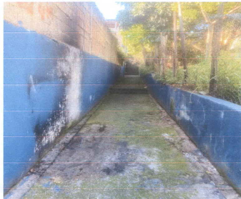
Rua Cerejeira, ao lado do nº 227
