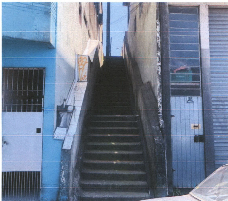
Rua Cafelândia, nº 573
