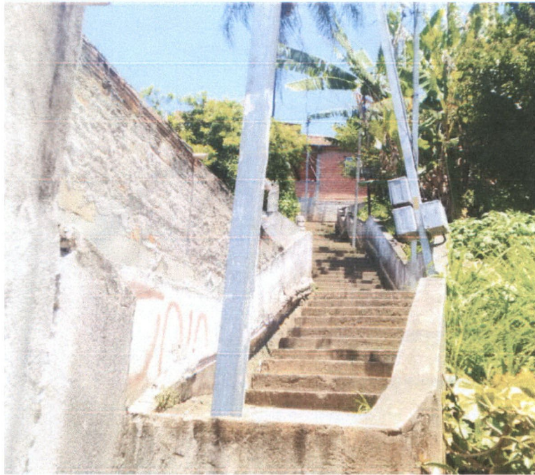
Rua Canal do Panamá, ao lado do nº 185
